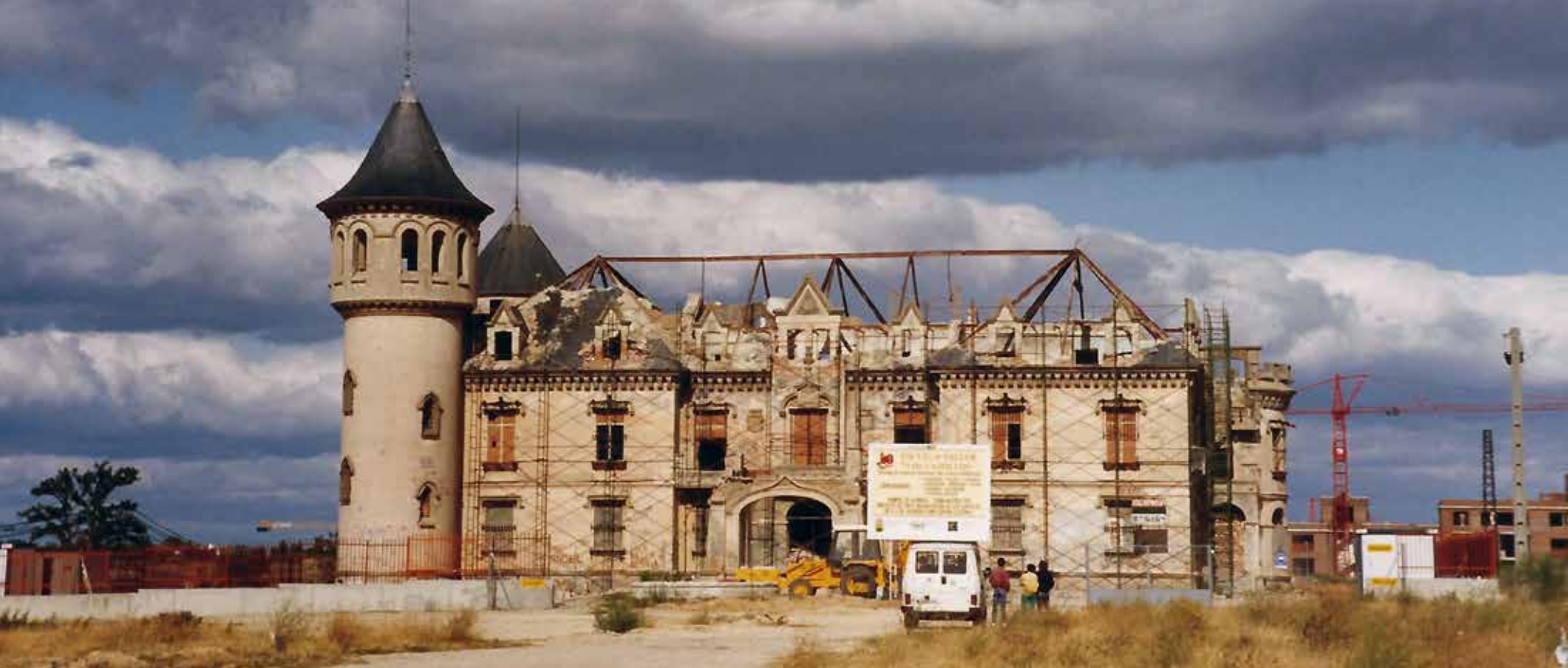
Los Castillos durante las obras de rehabilitación, 1993. Archivo José Coronado
